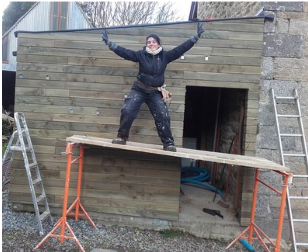
2 tréteaux pour faire un échafaudage
